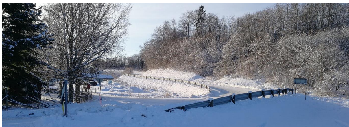
Figur 12: Krysningspunkt ved Bøndernes svingen, sett mot sørvest.
