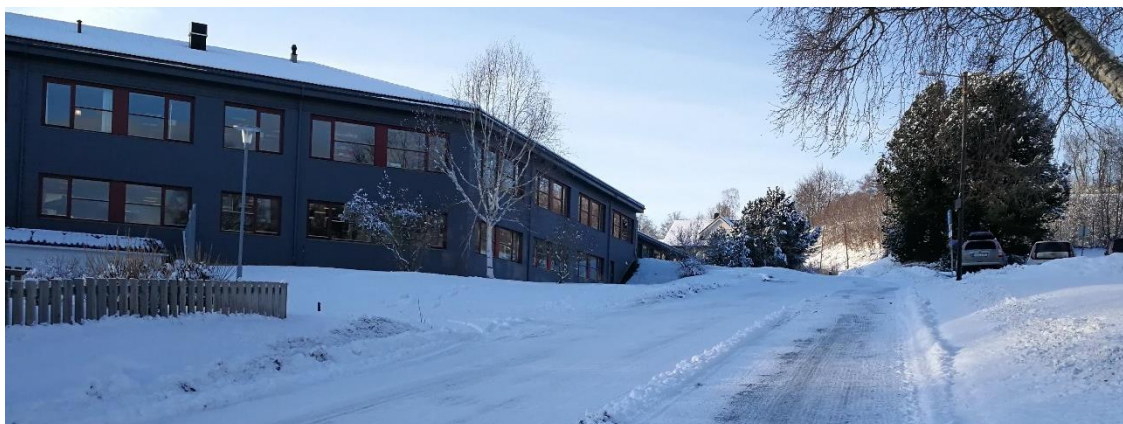
Figur 10: Krysningspunkt mellom Melhus videregående skole (til venstre i bildet) og Gimse svømmehall (til høyre i bildet), sett mot sør. Syklistene som kommer herfra kan oppnå svært høy fart.
