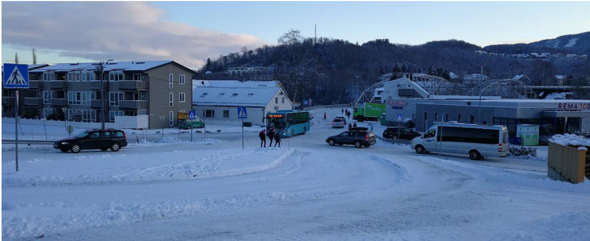
Figur 13: Krysningspunkt ved Martin Tranmæls veg og i Gimsevegen, sett mot øst.
